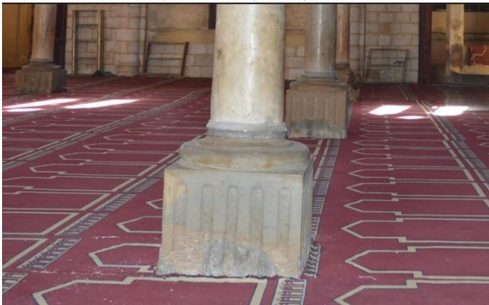
صورة (13) قواعد الأعمدة المربعة بها زخارف غائرة بمسجد القاياتي - العدوة ( من تصوير الباحث )
